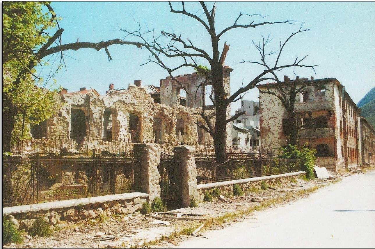
Slika 35. Bulevar – Mikačića kuća, 1994.
