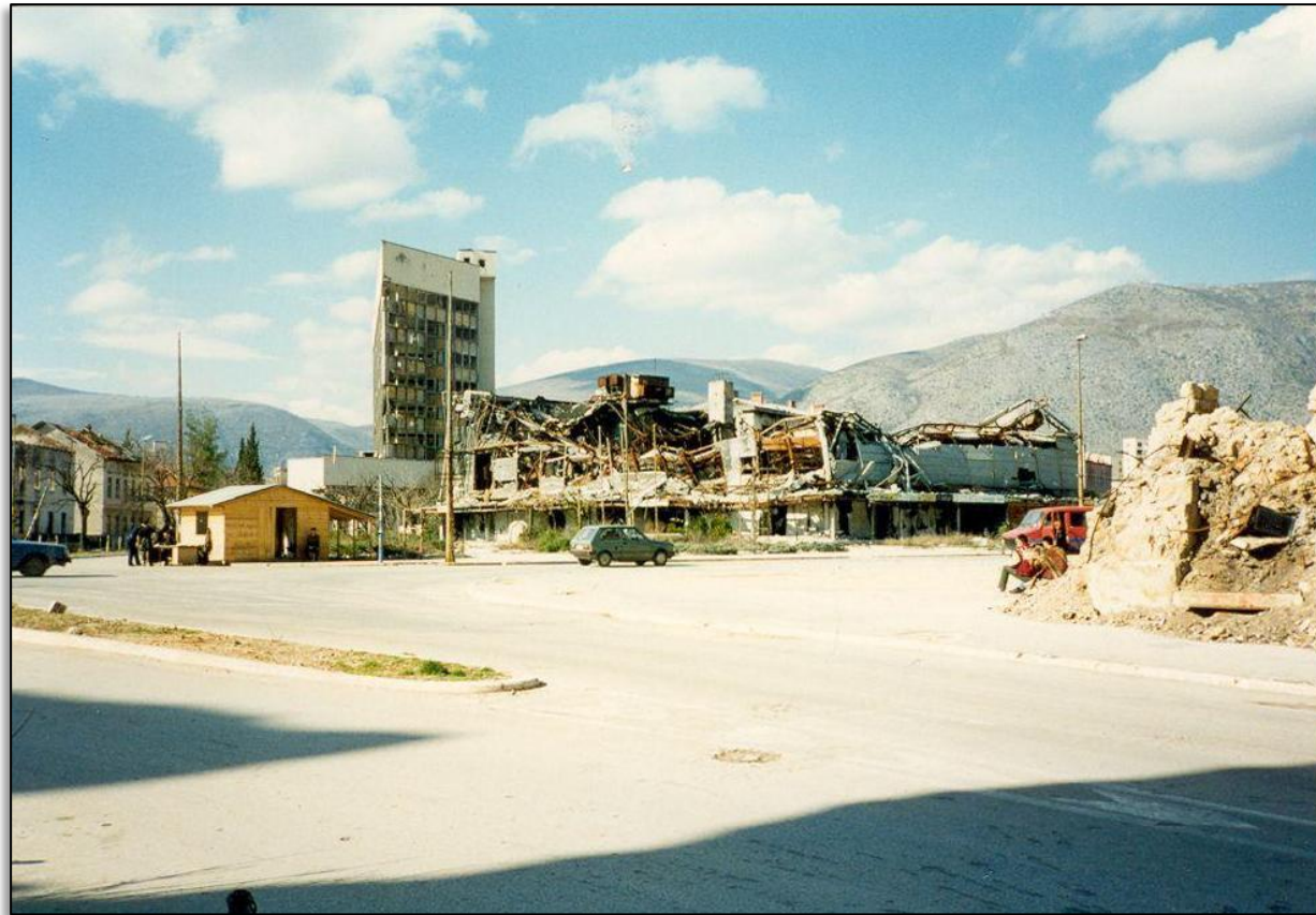
Slika 9. Robna kuća HIT, 1994.
