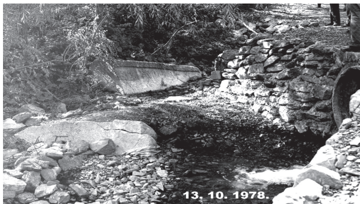
Slika 4. Stećci obrušeni u Orlovačkom potoku
