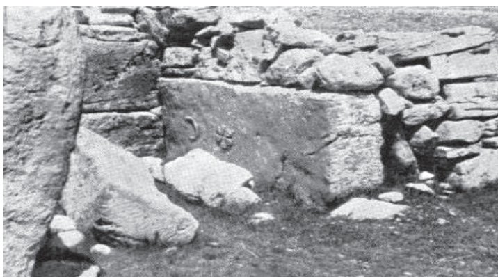
Slika 12. Sekundarna upotreba stećaka za izgradnju kapelice na nekropoli Dugo polje. 35
