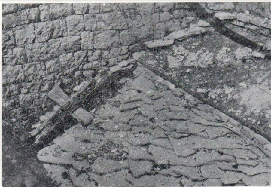
Sl. 13. Mlin Kraljevića u selu Žarkovu — detalj krova kamenom pločom
