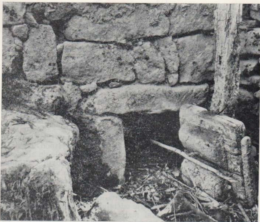
Sl. 2. Detalj zatvaranja otvora u bedemu drvenom lopatom
