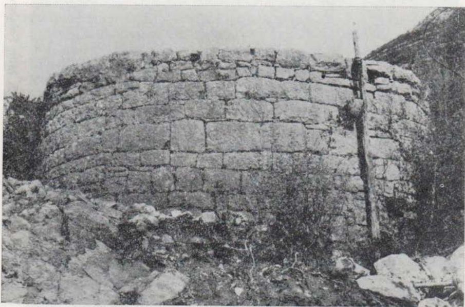
Sl. 6. Mlin u Dražinu Dolu — detalj zida
