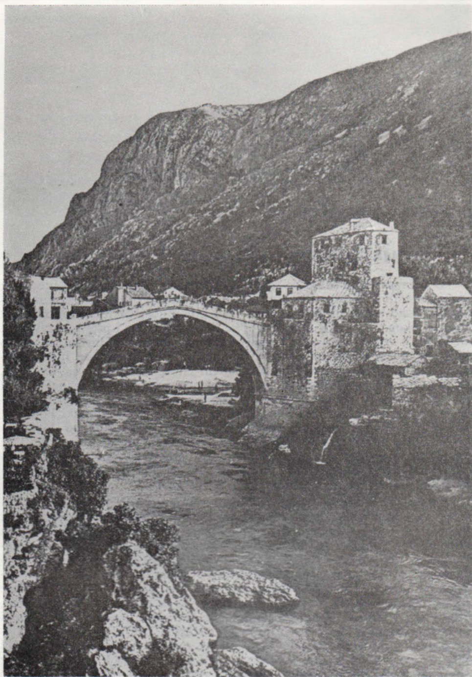
Sl. 1. Stari most u Mostaru, izgled sa uzvodne strane
